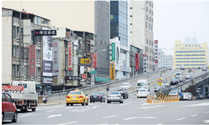
曾俊傑議員盼加速中博高架鐵橋的拆除進度。
