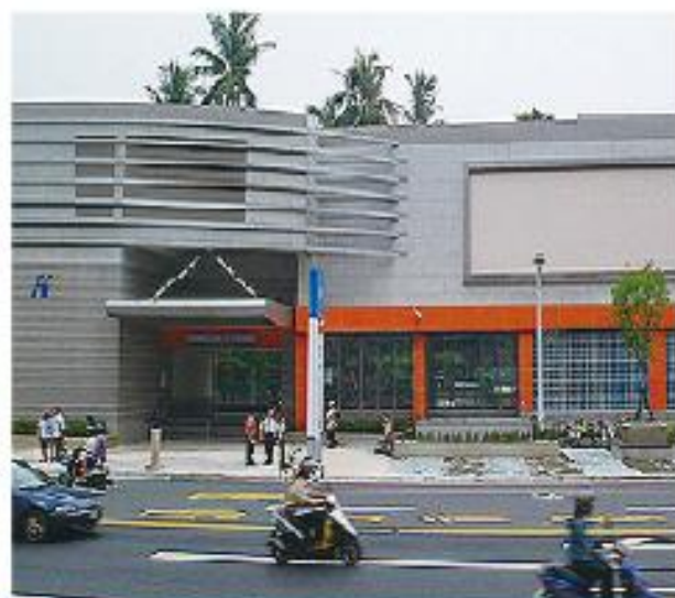
鳳山站1號出入口全貌，站體規模超過台鐵鳳山站。
