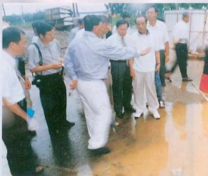
▲ 議長許福森率員勘查鳳山高速公路引道工程積水問題。
