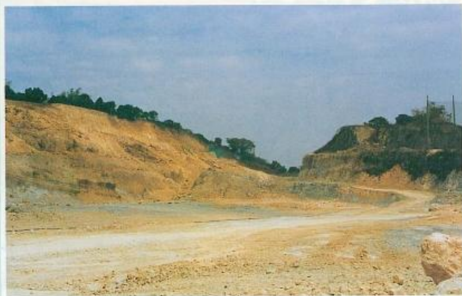
▲田寮礦區急需整地(危石處理)。
