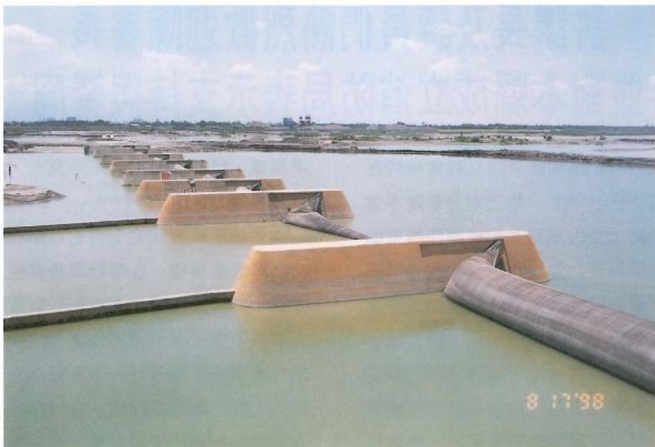
▲ 攔河堰工程現況。
