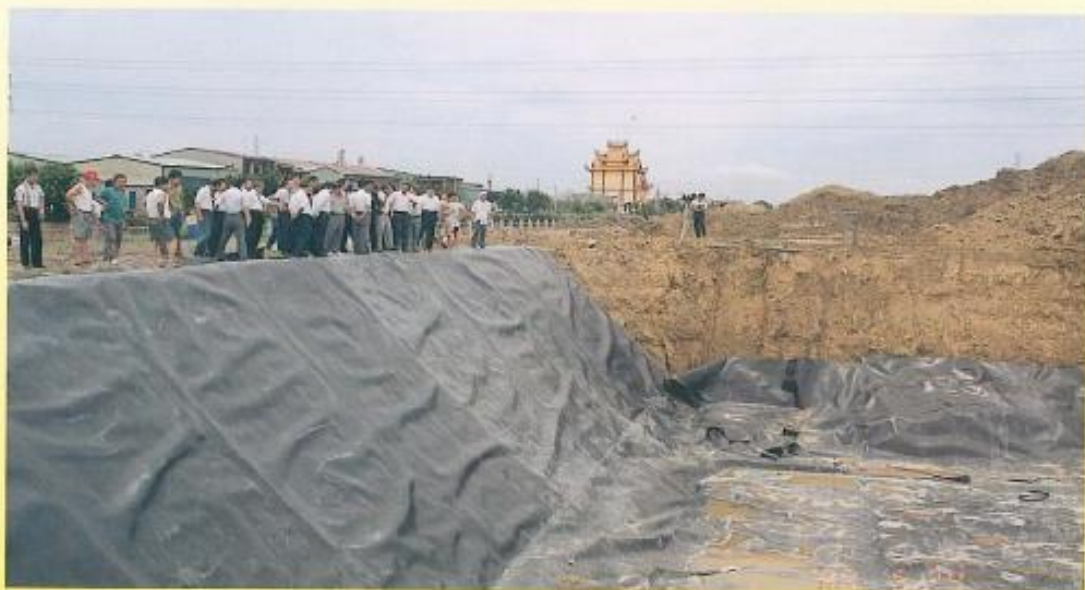
▲頂庄垃圾場目前的施工狀況。
