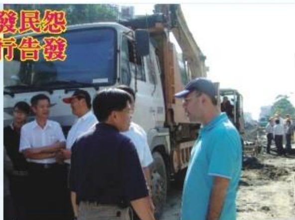
◆台電地下電纜管路工程施工引發民怨，議員黃璽文親赴現場了解。
