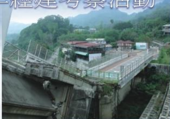
◆九二一重創台中縣石岡鄉的石岡壩水利設施
