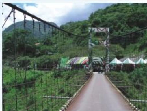
桃源鄉復興村拉法勒吊橋
