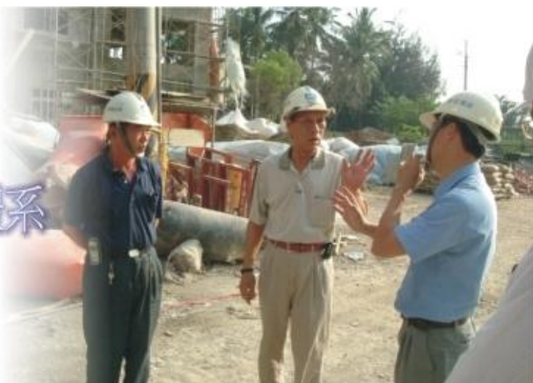
◆ 監督勵志國宅施工品質，耿議員不辭辛勞，一有空就往工地勘查。
