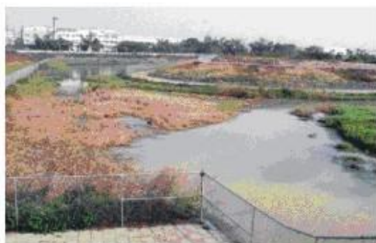
●本洲工業區的廢水處理場。
