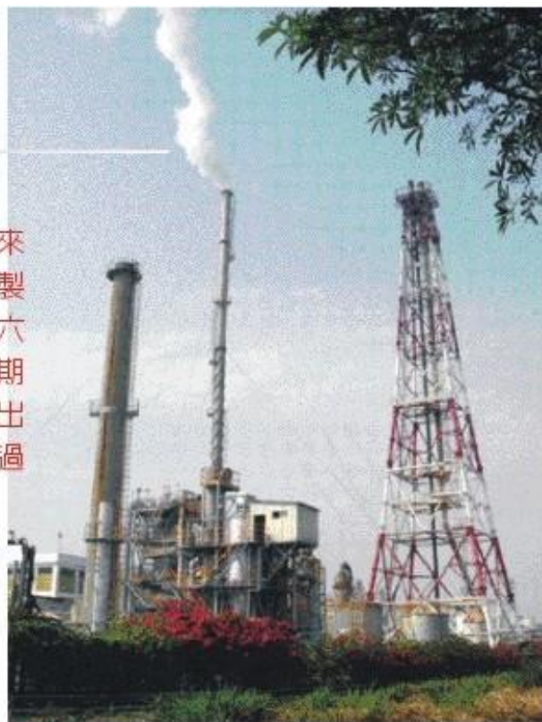
●大社石化工業區煙囪林立。
