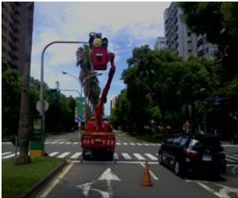
標誌維修高空作業
