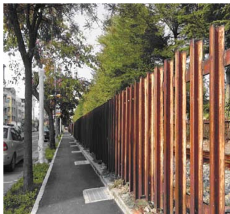
第二施工標完工景觀
