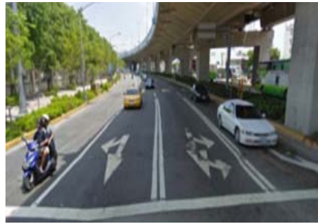
自由路出口匝道現況-2
