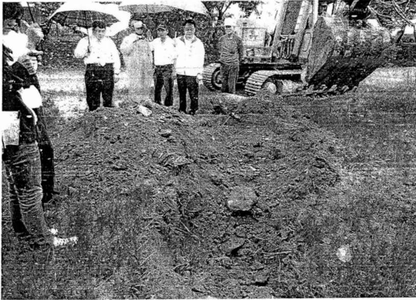
隔離綠帶開挖情形（內容物除土壤外尚含些許礫石、磚塊等）
