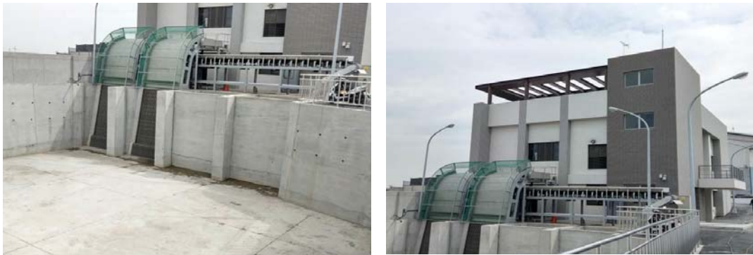
石螺潭抽水站
