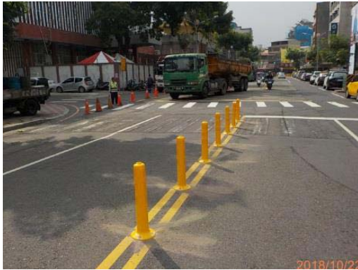
圖 44 鳳山區曹公路/信義街/鳳明街口 增設軟質分隔桿
