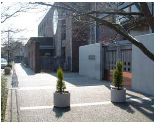
■ 写真 3-1-1 サービス部門の防犯対策例 ・給食室への搬入車両用に門扉を設け単独のセキュリティの領域をつくっている。手前が正門、正面が給食室への搬入車両用の門扉。
