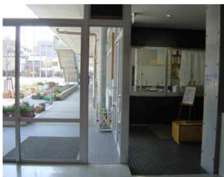
■ 写真 4-2-4 視認性が高い出入口の例 ・玄関の扉をガラスにすることによって、高い視認性を確保している。
