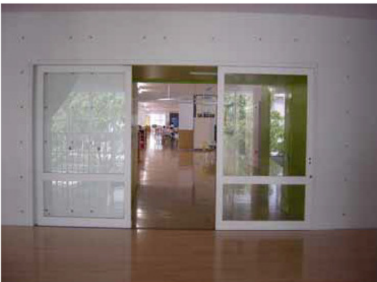
■ 写真 7-1-3 地域開放部分と非開放部分との区画管理の例 ・見通しのきくガラスドアで領域を区分けしており、施錠することも可能となっている。
