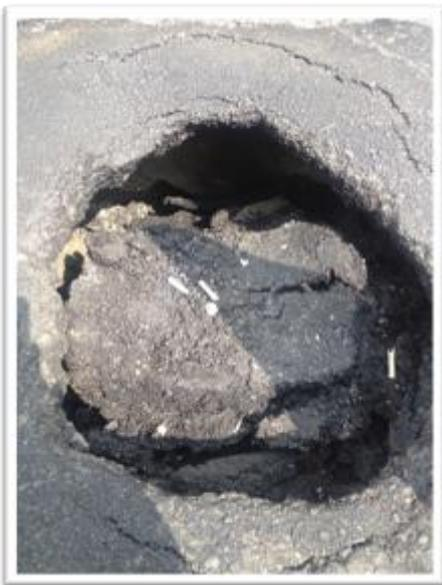
議員李雅靜表示，早年清朝時期鳳山溪經前鎮河連通海面而有舟楫之利，現之訓風砲台當時即為防衛之用，後再加曹公圳之開闢，鳳山市區水道圳渠密集。現由於時日變遷，古老水道已因砂石淤積而成平地，河床亦因淤塞而成淺灘，由於地貌之變遷，加上光復初期，水溝涵洞之施工法不如現在之精湛，固有變形漏水之狀況，而導致泥沙流失、地層下陷之情事，如現鳳山區中山路與大東
