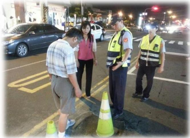
水利局派人到現場會勘後，認定係當地有一條已有 20 多年的排水箱涵滲水，造成地層下陷，因地表有鋪設柏油，無法由外觀洞悉，但經車輛輾壓後破裂見洞。水利局為維護用路人安全，於當日中午馬上進行填補工作。
