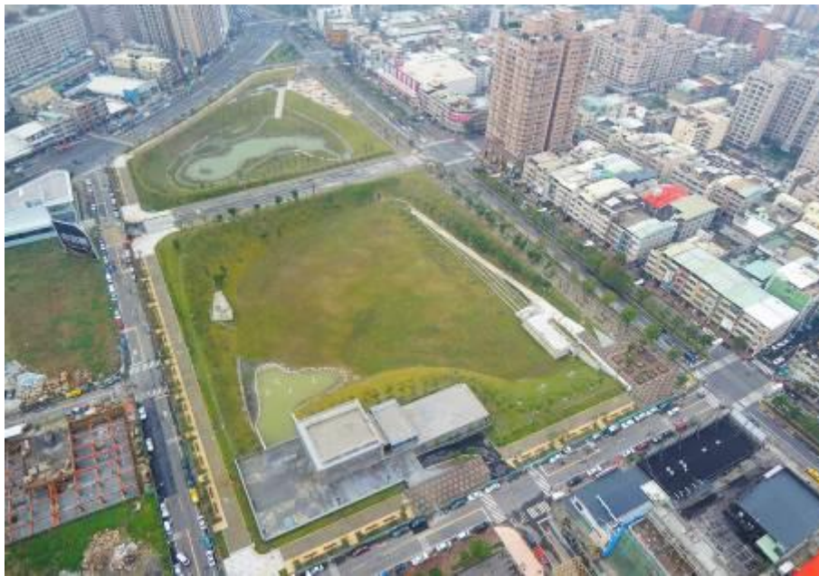
三民區寶業里滯洪池
