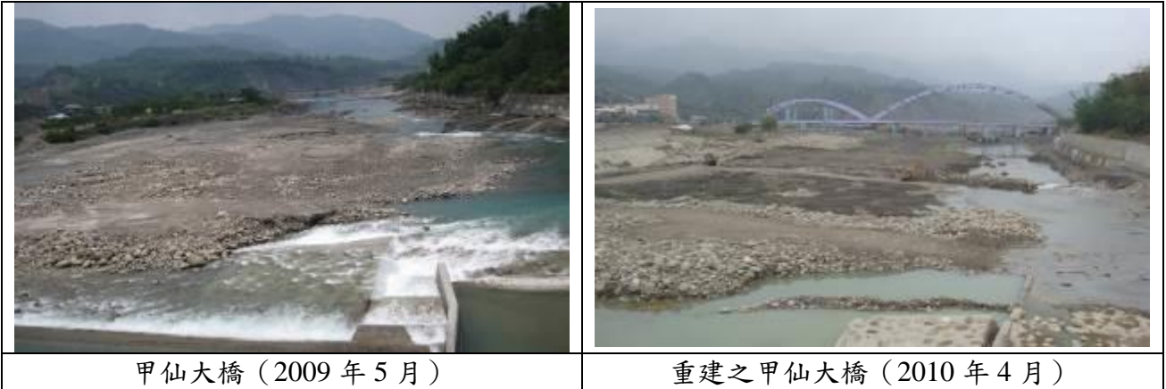
照片 2 2009 年莫拉克颱風期間，位於高屏溪支流旗山溪的甲仙攔河堰及甲仙大橋因豪雨及承接上游夾帶大量泥砂之洪水，造成堰址及橋墩多處損毀。
