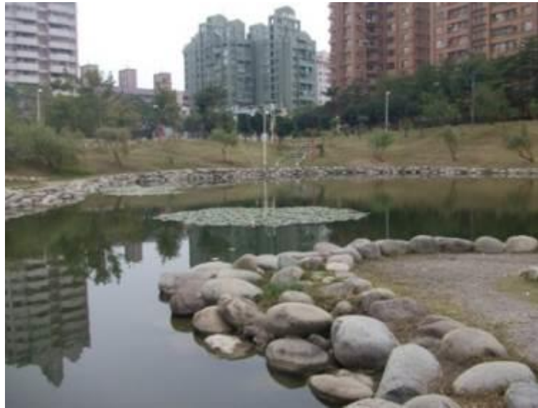
照片 11 位於高雄市三民區之本和里滯洪池為兼具生態、遊憩、景觀綠化等附加用途之滯洪設施，其總佔地面積約為 3.14 公頃，汛期時計畫可提供 11 萬 m 3 滯洪量（王筱雯等 5 ，2009）
