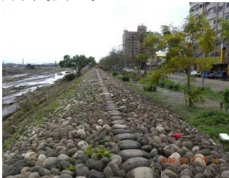
照片 5 旗山溪堤防未受損段 (2009/08)
