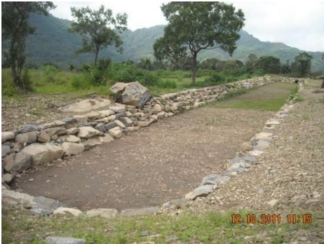
那瑪夏區民權國小校區重建工程之滯洪池
