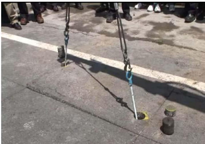
圖十七 以吊車將切割完成的手孔蓋板吊起。
