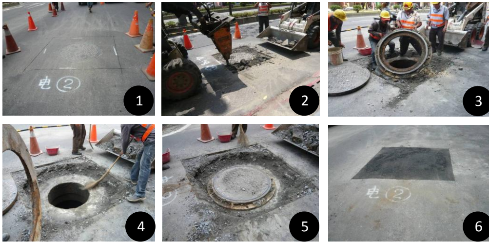
圖七 管線單位進行人(手)孔蓋下地
