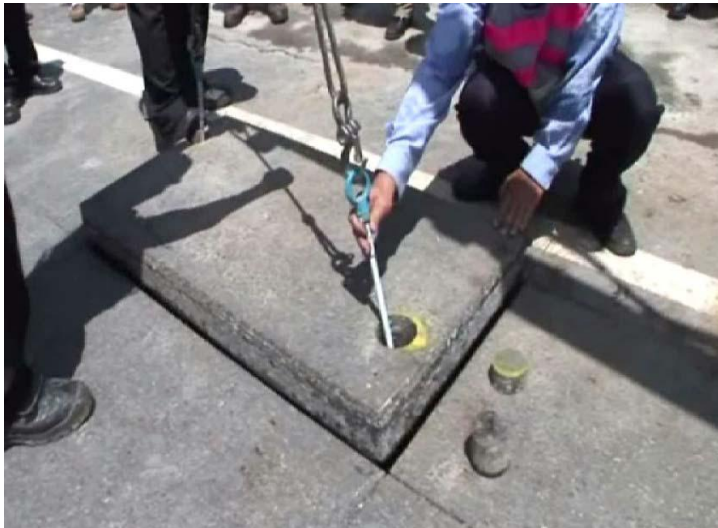
圖十九 蓋回手孔蓋板確認平整無晃動。
