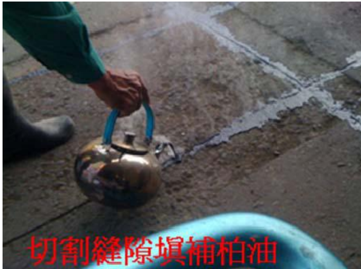
圖二十一 切割縫隙填補 柏油
