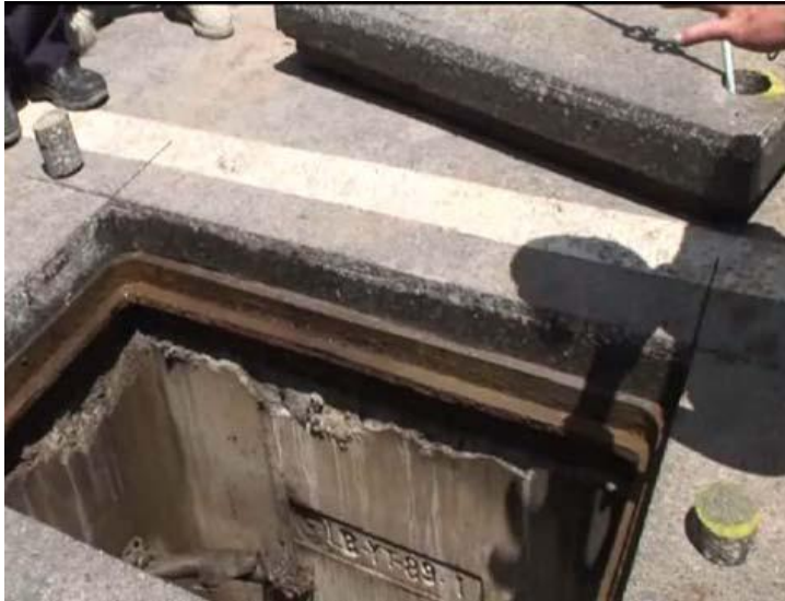
圖十八 手孔蓋板吊起進行線路工程作業。
