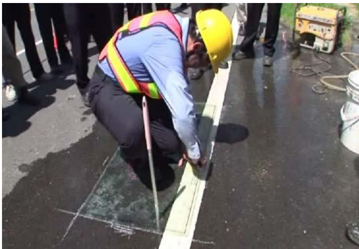
圖十六 於手孔蓋切割線切割樣板四個邊畫上切割線。
