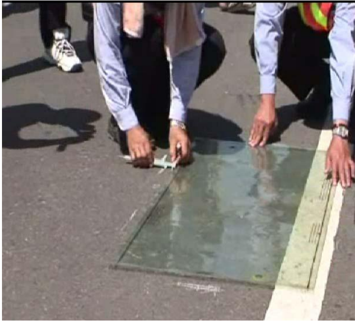
圖十五 以游標卡尺來調整手孔蓋切割樣板與手孔蓋相對邊線之距離。
