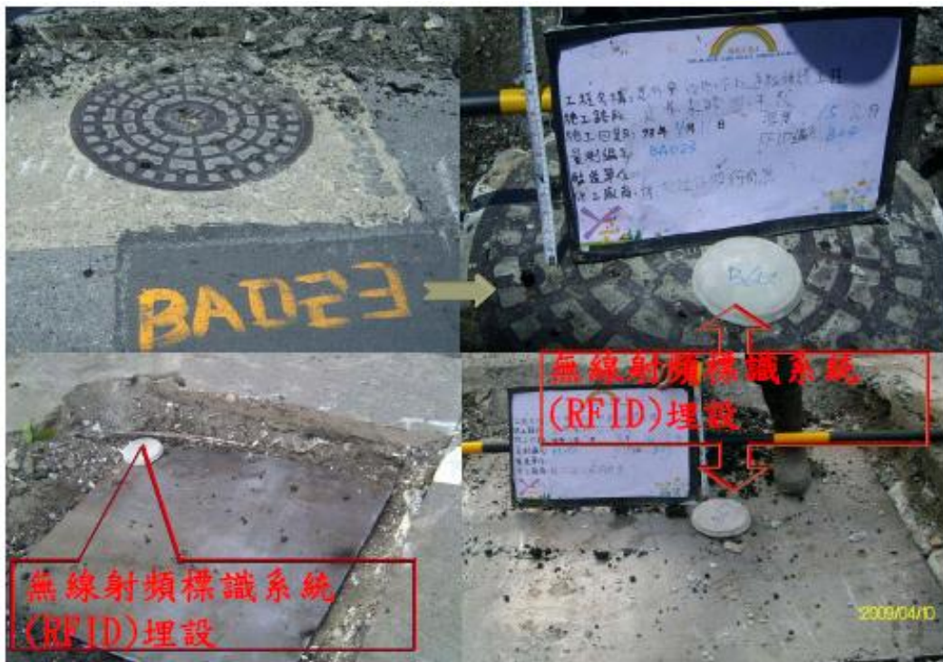
圖十 孔蓋下地後埋設定位器
