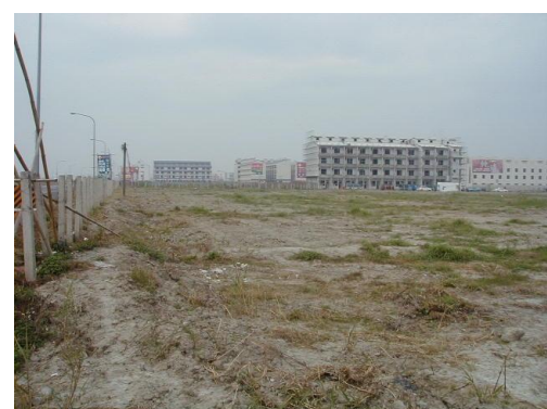
楠梓區文小 1 施工前
