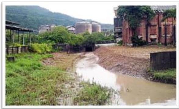
水災害；三是山區高水頭及高流量逕流進入下水道系統，出口銜接鼓山運河處又無法宣洩，強大壓力使水體於沿線低窪區冒出，造成低窪區淹水災害。
