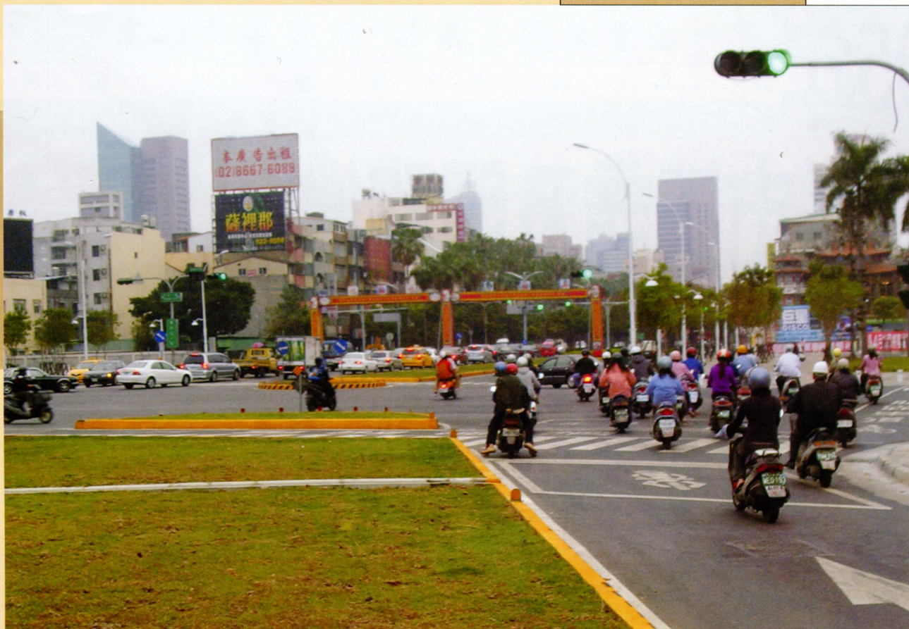
■中山、民生路口機踏車道旁兩處的分隔島錯誤設計，致使轉彎車與後方來車搶道問題嚴重。
