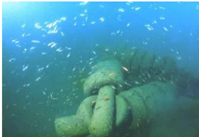
可投放在柴山外海之水泥電線桿製作之人工魚礁， 當成保育礁體。
