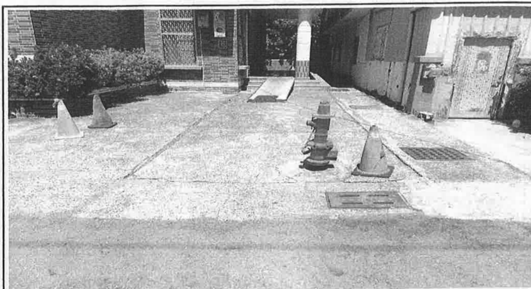
說明：力行路 5-1 消防栓位置圖 1
