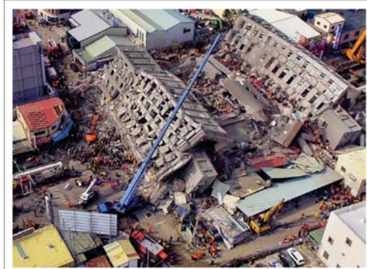
2016 年除夕前夕，台南發生 6.6 級地震，維冠金龍大樓倒塌造成 115 人罹難，此案便是建築師與鑽探技術公司提供不實簽證所致，由此可見行政委外仍須建立嚴謹的防弊及抽驗機制。（照片擷取自網路）
